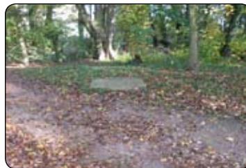
Regard du réseau d'assainissement
