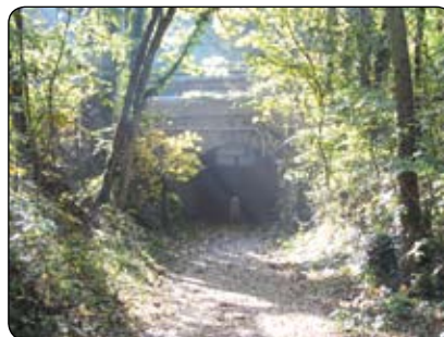
Le souterrain qui passe sous l'autoroute et permet de rejoindre l'autre partie du parc de Saint-Cloud
