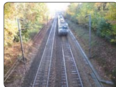
Vue de la passerelle
