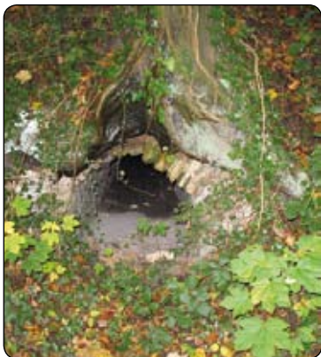
Sortie probable d'un ancien aqueduc sous la souche d'un charme
