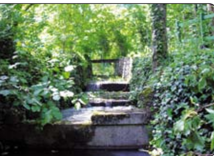
Les filtres de la Palette, à l'amont du canal
